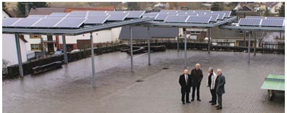
... und der Pausenhalle sind mit Photovoltaik-elementen ausgestattet.
